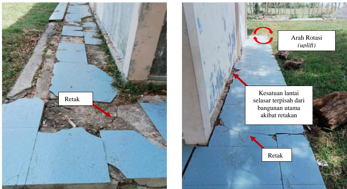
Gambar 4. Pola Retakan pada Selasar Sekolah
