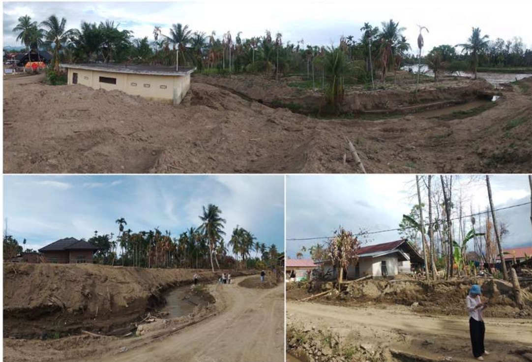
Gambar 3. Gambaran kerusakan Kawasan Pasca Bencana Banjir Senyar 2025
