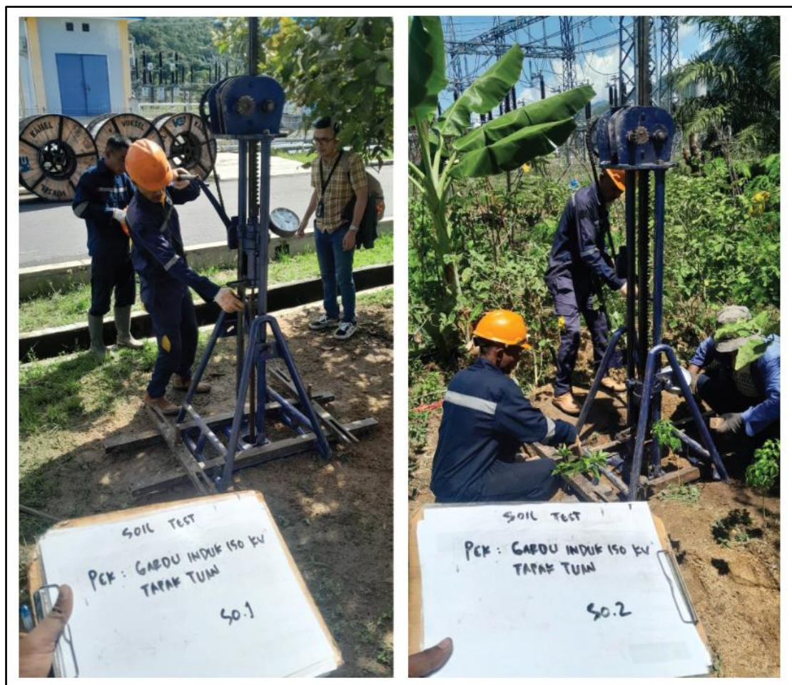
Gambar 2. Pelaksanaan CPT pada dua lokasi yang berbeda yaitu S01 dan S02 PT. PLN (Persero) UIP SUMBAGUT
